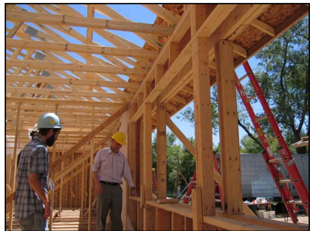
Fig. 3: Double stud wall framing
